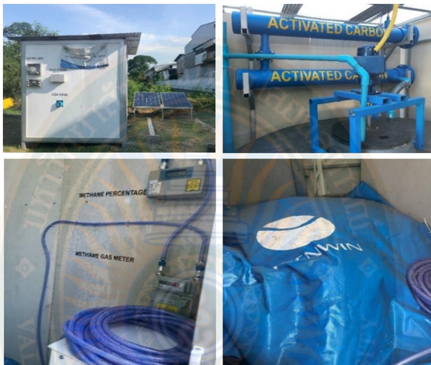
ภาพที่ 30 ระบบการผลิตก๊าซชีวภาพระดับต้นแบบหลังจากดำเนินการสร้างเสร็จสิ้น
