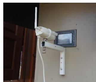
จุดติดตั้งที่ 3
