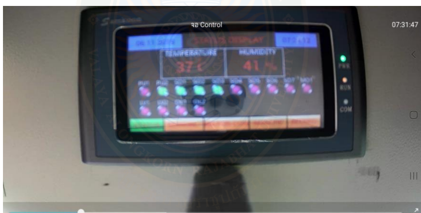
ภาพที่ 66 กล้องวงจรปิดแสดงหน้าจอสถานะการทำงานของอุปกรณ์ต่าง ๆ
