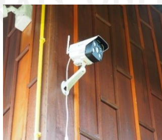
จุดติดตั้งที่ 2
