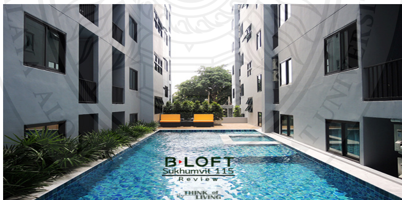
ภาพที่ 2.6 อาคารโครงการ บี - ลอฟ สุขุมวิท 115 คอนโด
