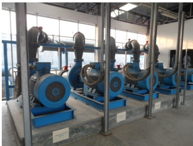
ภาพที่ 2.13 เครื่องสูบน้ำประปา
