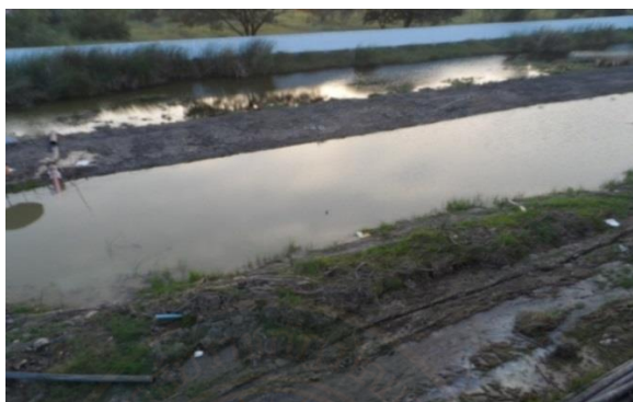
ภาพที่ 2.11 บ่อพักตะกอนบ่อที่ 1
