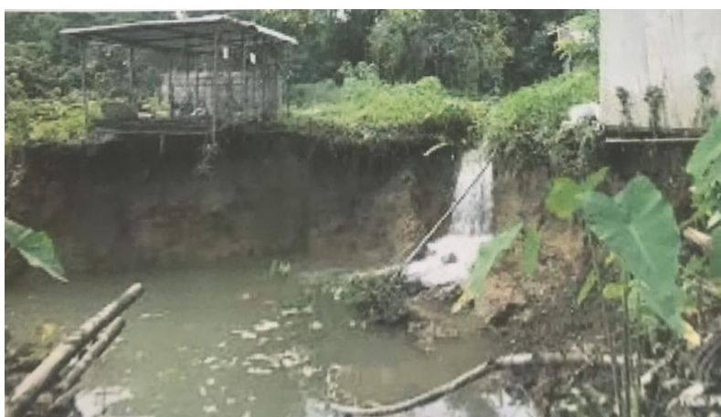
ภาพที่ 10 การยุบตัวของดินเป็นหลุมที่เกิดจากแผ่นดินไหว
