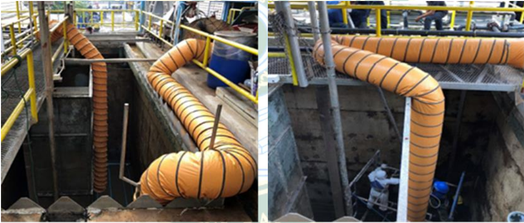
ปัดตกตะกอนก่อนการติดตั้งแผ่นทิวบ์เซ็ทเทิลเลอร์ ขณะเตรียมพื้นที่ก่อนการติดตั้ง
