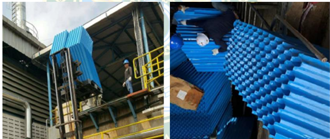
ติดตั้งคานรับแผ่นทิวป์เซ็ทเทิลเลอร์ภายในบ่อตกตะกอน
