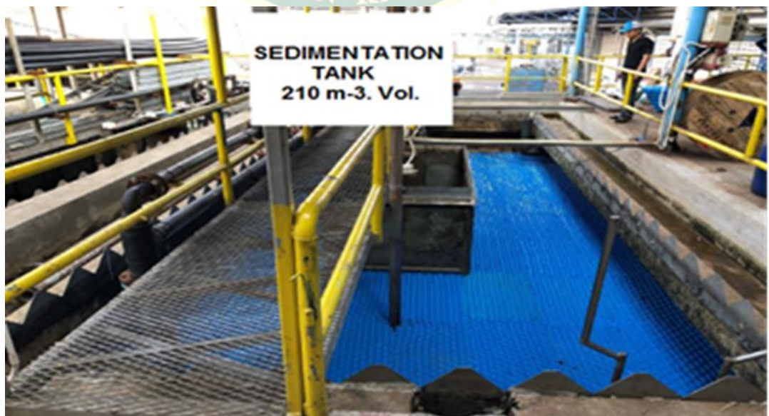
แผ่นทิวป์เซ็ทเทิลเลอร์เข้าสู่พื้นที่และติดตั้ง
