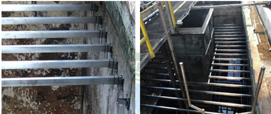
ติดตั้งคานรับแผ่นทิวป์เซ็ทเทิลเลอร์ภายในบ่อตกตะกอน
