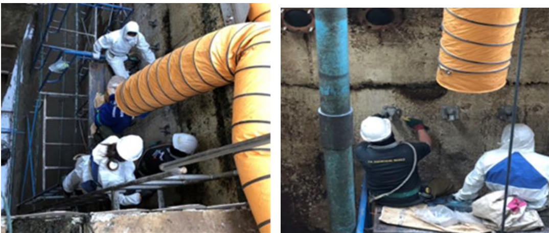
ตั้งนั่งร้านวางตำแหน่งการติดตั้งคานรับแผ่นทิวบ์เซ็ทเทิลเลอร์
