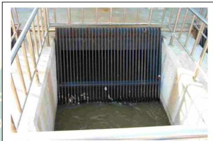
ภาพที่ 2 แสดงตัวอย่างตะแกรงหยาบ ตะแกรงละเอียด ที่มา: Zaher (2019)
